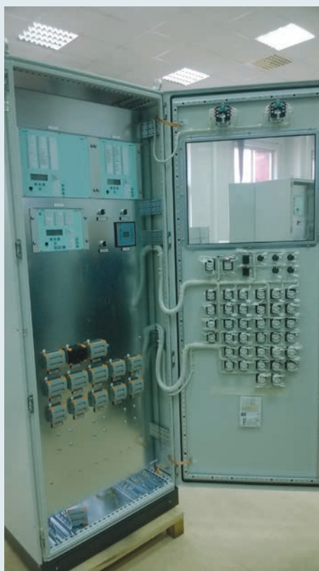
Рис. 3 Внутренняя часть шкафа с блоками FAME 6/6+1 и измерительными клеммами PTU 4-MT-P и PTU 6-T-P
