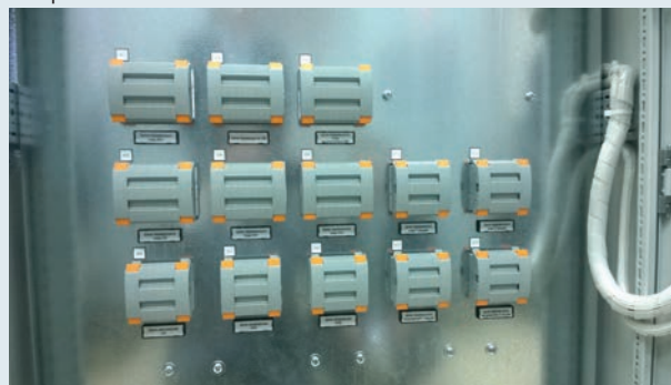
Рис. 2 Внешняя панель шкафа с блоками FAME 6/6+1
